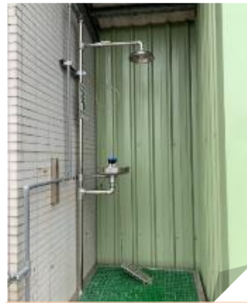
水處理區緊急沖淋設備
