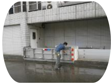
水患因應-設置擋水閘門
