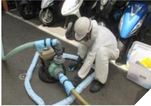
進行化學槽車卸料檢點
